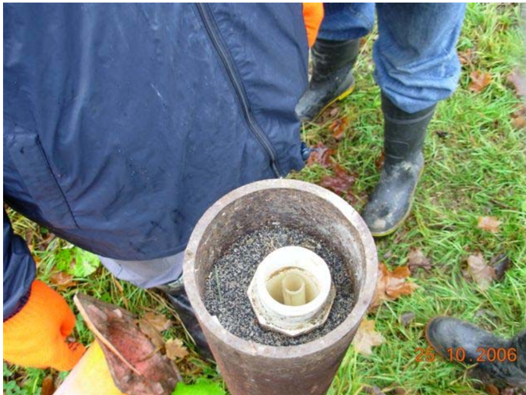
Photo 6. Vue de dessus d'un puits d'observation permettant de visualiser le tubage de protection, le tubage intérieur en PVC et la tubulure mise en place pour la purge. Notez que l'espace annulaire situé au-dessus du sol a été rempli de matériel granulaire pour supporter les tubulures (MDDEP, 2006)
